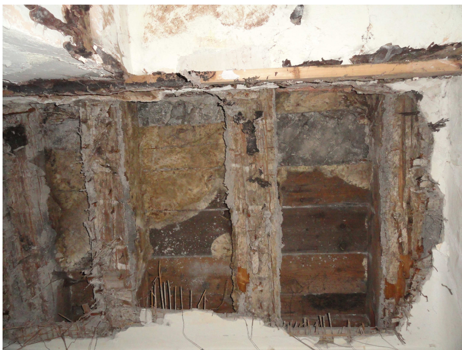
5. Zřícený pohled, totální narušení stropních trámů dřevomorkou, betonová vrstva nad záklopem – místo 2
