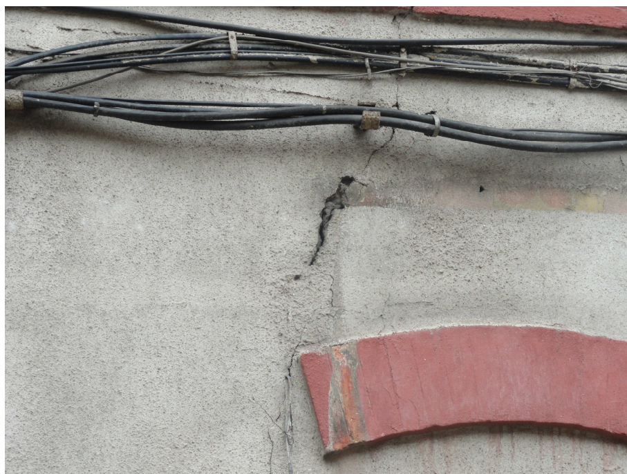
4. Trhliny ve stěně východního průčelí
