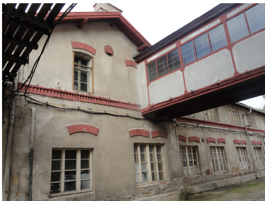
2. Východní průčelí kancelářské budovy s mostem k těžní věži Jámy Robert, je zřejmé dodatečné osazení mostu a zazdění původního okna
