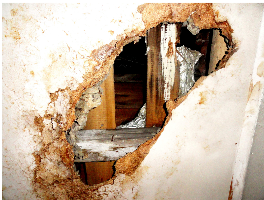
11. Otvor v podhledu nad schodištěm v patře – místo 9
