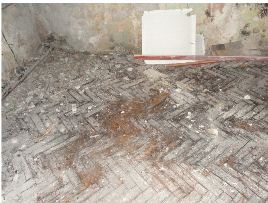
13. Destrukce vlýskové podlahy vlivem dlouhodobě působící vlhkosti a dřevomorky – místo 3
