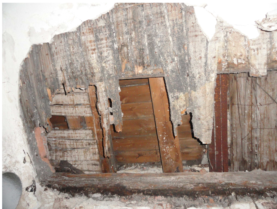
7. Destruovaný podhled, dřívější sanace dřevěnými trámky a ocelovými nosníky - místo 1 levá část
