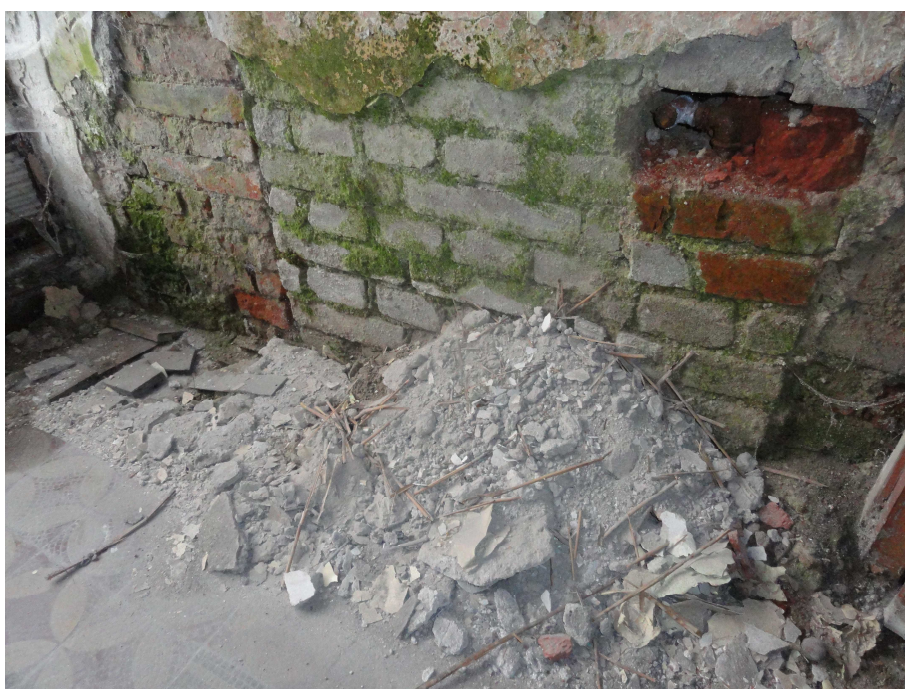
14. Vlhké zdivo s řasovými výkvěty (nefunkční nebo žádné hydroizolace), je patrné použití různých druhů cihel a neprovázaná přízdívka – místo 5a
