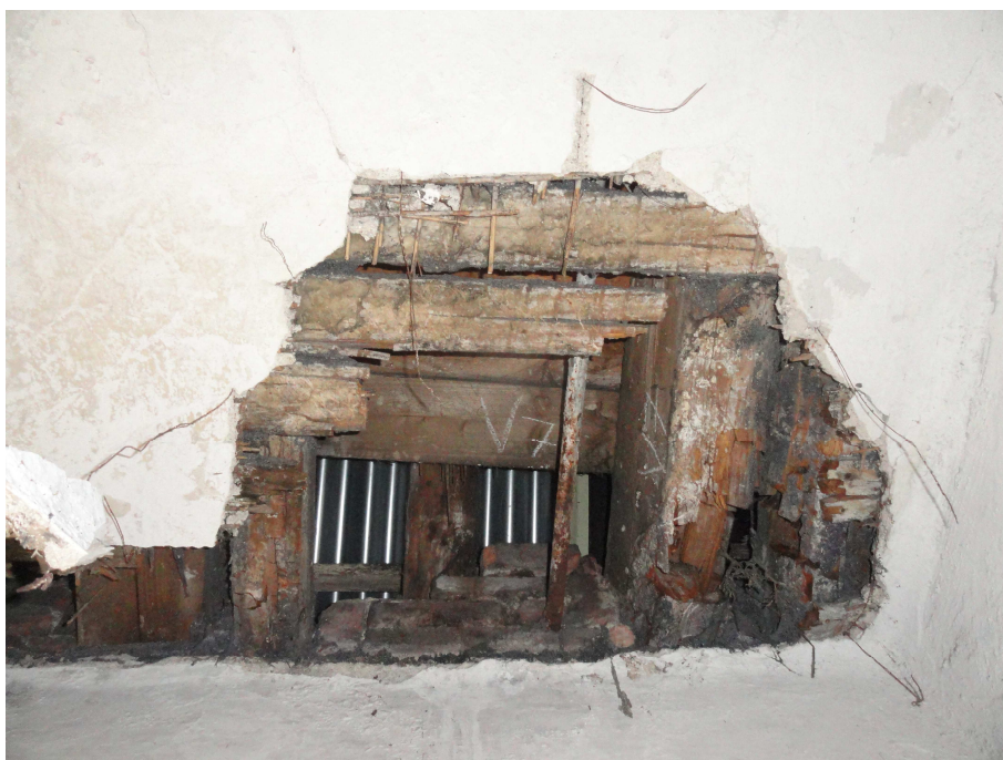
9. Zásadně narušený (přerušný) stropní trám v patře - místo 6
