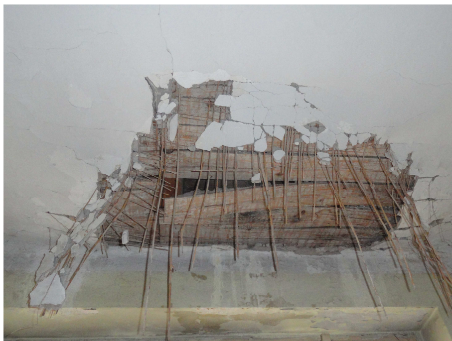
8. Zatékání a propad podhledu - místo 4
