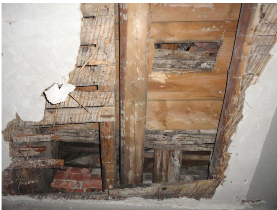
10. Nad stropními trámy a záklopem v 1. patře je patrné ponechané poškozené dřevo střešní konstrukce v patře - místo 8
