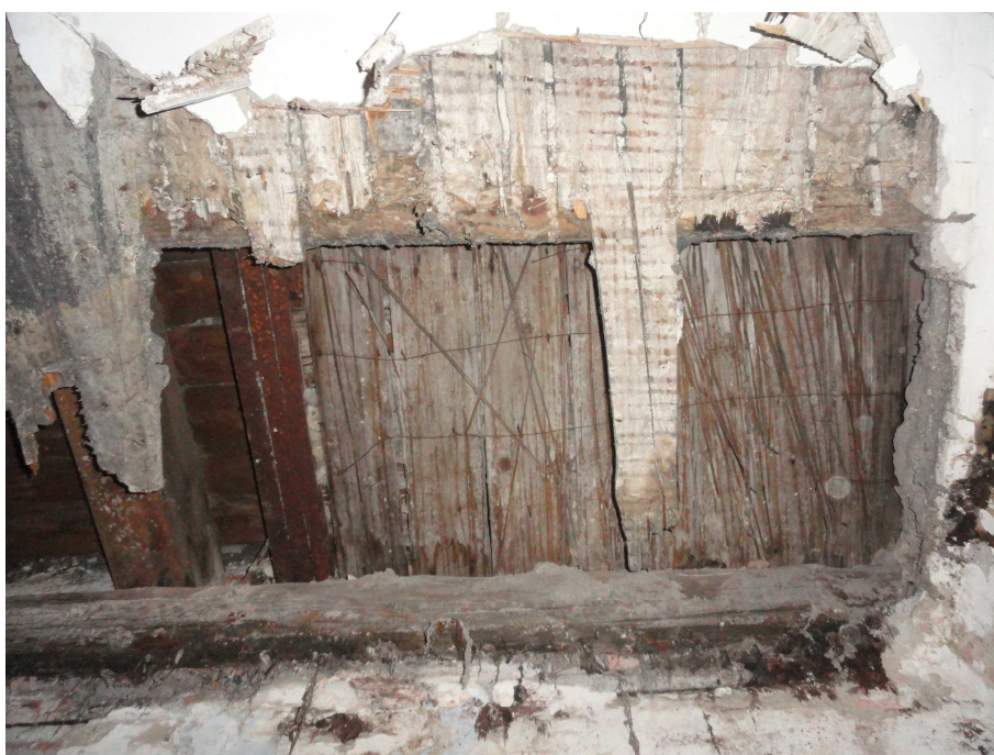
6. Zřícený pohled, narušené trámy dřevomorkou – místo 1 pravá část
